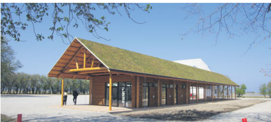
Hluti þjónustumiðstöðvar sem verið er að byggja við Gyldensteen-ströndina.
